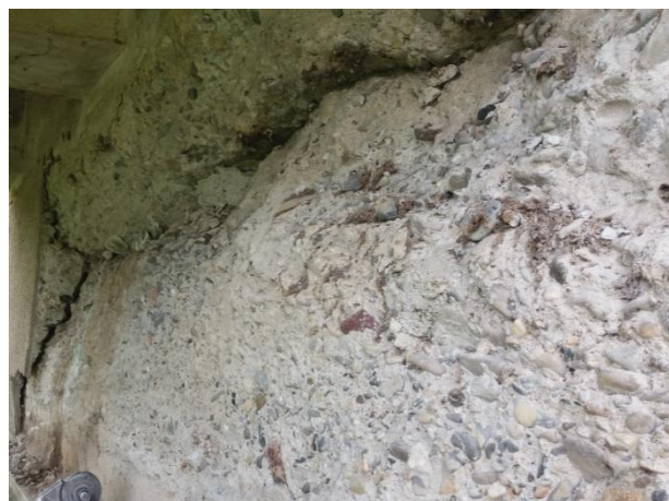
Ammaloramenti spalla SPSX - si osserva la ripresa di getto sulla spalla appena al di sotto del piano di intradosso dell'impalcato
