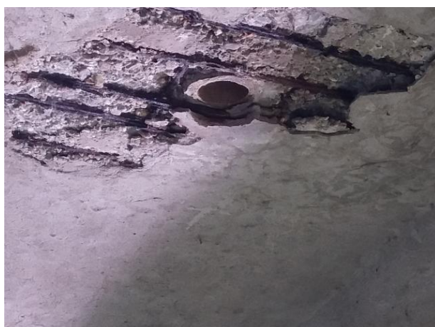
Dettagli della soletta degradata della campata sinistra
