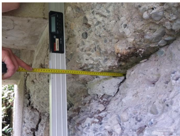
Ammaloramenti spalla SPSX - si osserva la ripresa di getto sulla spalla appena al di sotto del piano di intradosso dell'impalcato
