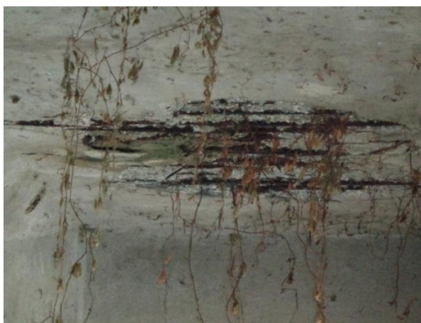
Dettagli della soletta degradata della campata centrale
