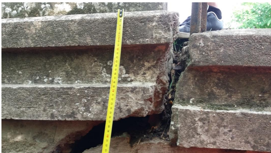
Disassamento lato di monte Spalla SPDX e muro andatorio
