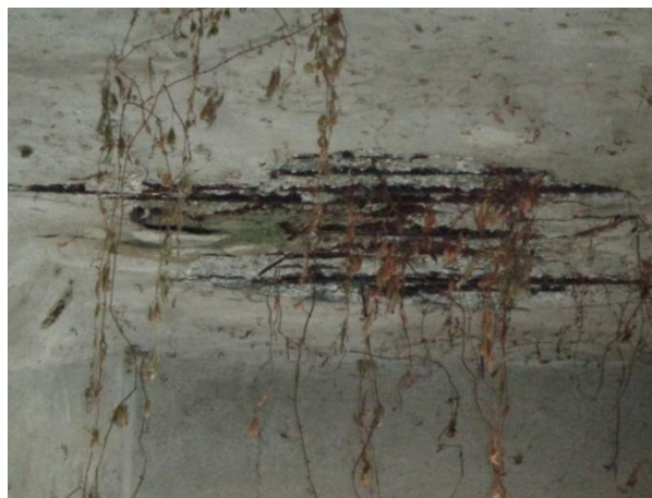
Dettagli della soletta degradata della campata centrale
