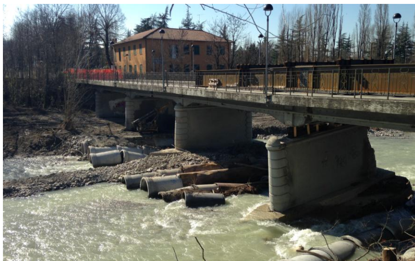
Esempio di struttura di supporto all'estradosso dell'impalcato (intervento analogo)
